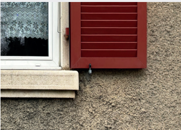
L'épaisseur du crépi isolant minéral se définit par les encadrements en pierre à conserver.
